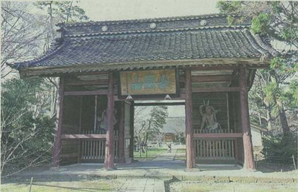
山門の一部が修復された五智園分寺(上越市)
